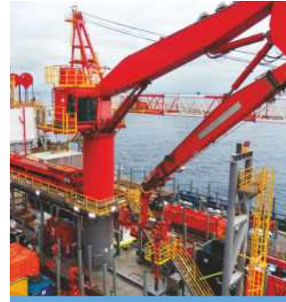
GRUAS E GUINDASTES DA PLATAFORMA
