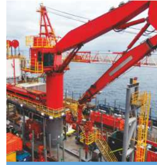
GRUAS E GUINDASTES DA PLATAFORMA
