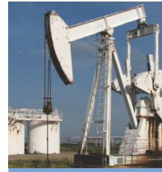
CHEVALETS DE POMPAGE
